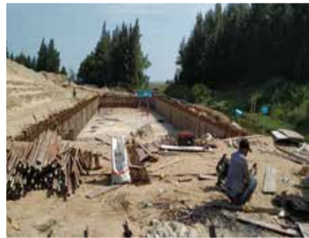
吴阳镇集中尾水处理工程建设现场
