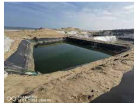
养殖散户依托原有养殖池改建的三级处理设施
